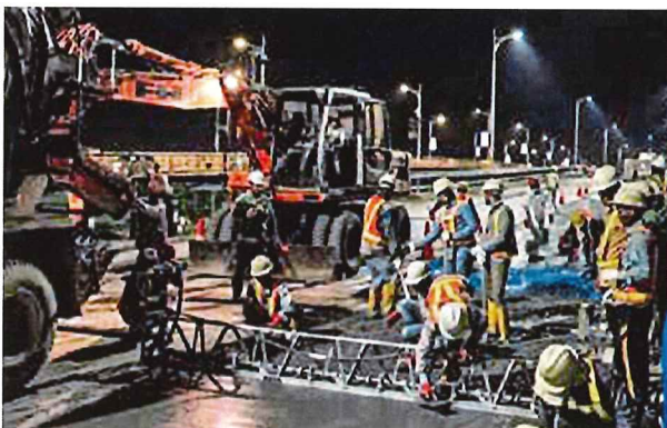
現地初のSFRC舗装作業
