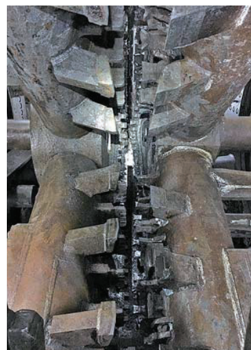
地中接合のカッターヘッド部
