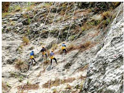
高所作業を行う現地スタッフ育成の様子
