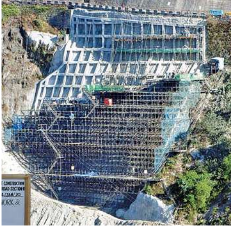
グラントアンカー工の足場と吹き付けの砕工
