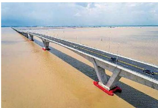
道路工事を17年に完成させた。当社は総延長のうち、5・4キロに及ぶ橋梁を急速施工し、海上架設の約4・4キロ区間は13カ月で完成させた。
