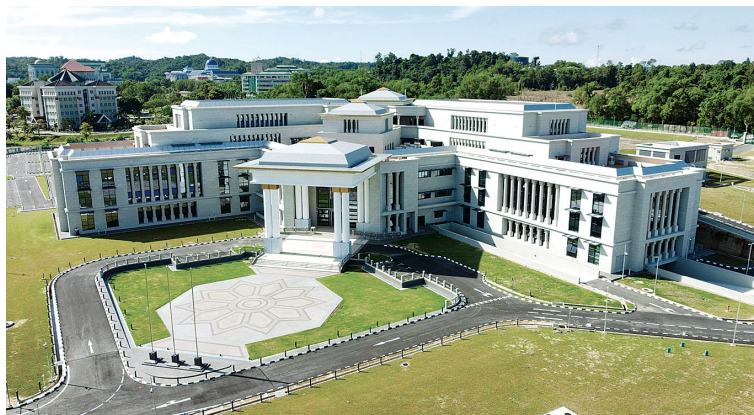
中央銀行本庁舎の外観
