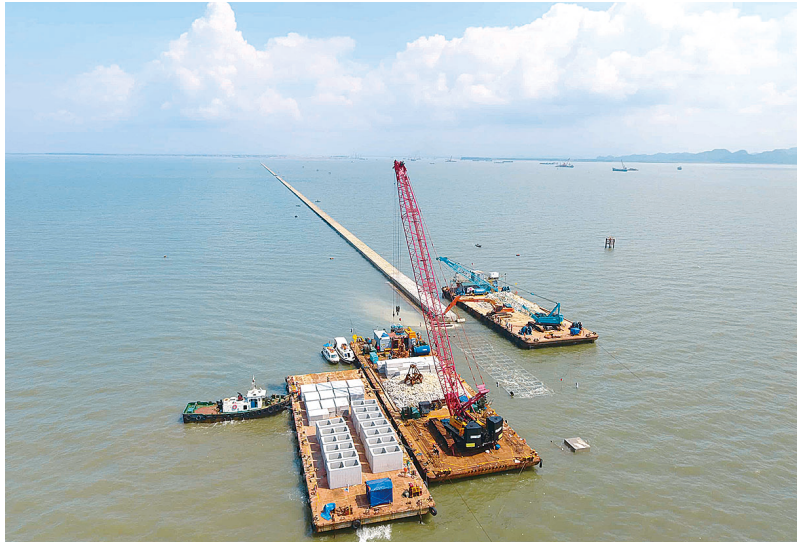
防砂堤の海上工事の作業状況
