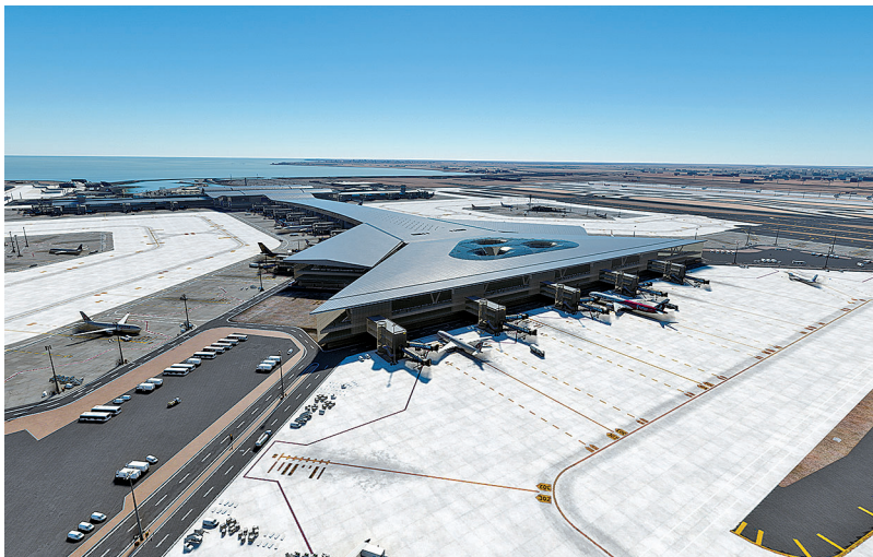
拡張工事エリアの全景
