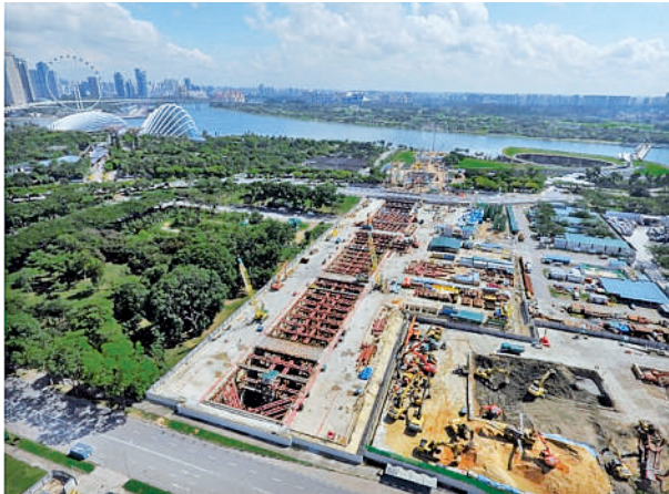
Thomson-East Coast 線 ガーデズバイザベイ駅施工状況
