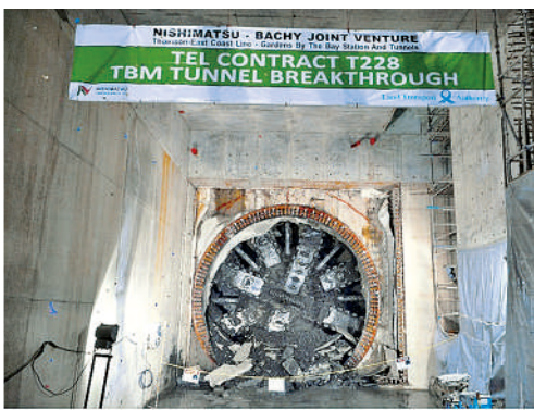
ガーデズバイザベイ駅到達直後のシールド機
