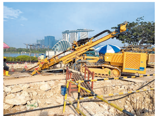
曲線削孔によるマリーナ貯水池直下の地盤改良
