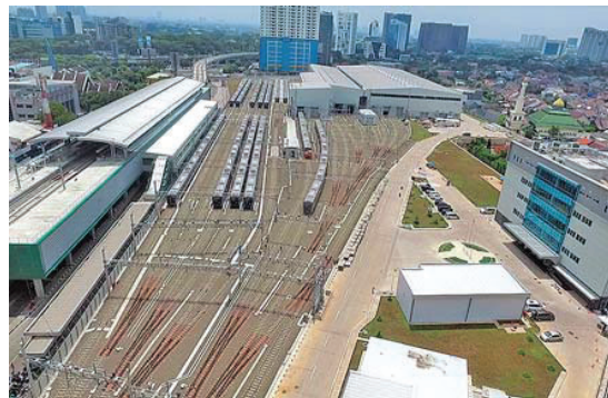
管理棟や車両検査場・工場などが集積する車両基地
