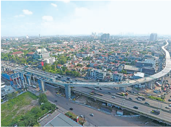
高速道路・国道直上で施工中の急曲線長大橋
