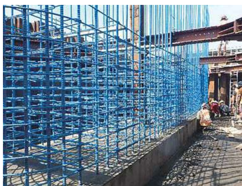
橋脚の鉄筋組み立て作業
