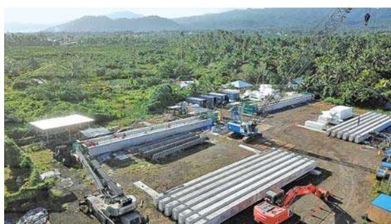
現地に整備した主桁の製作ヤード
