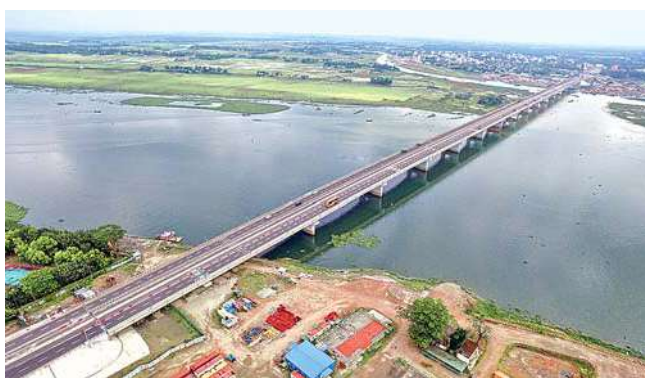
2車線から6車線に改良された橋長1410mの Gum ティ橋
