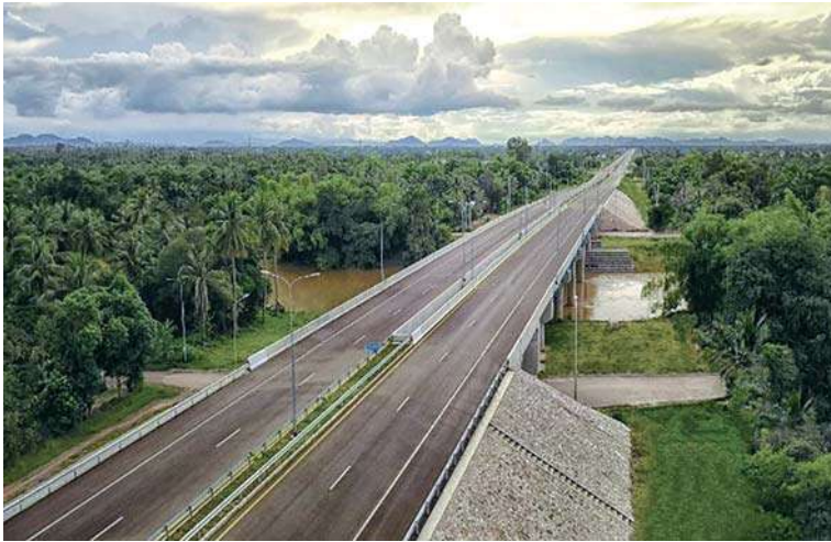
バイパスの完成状況
