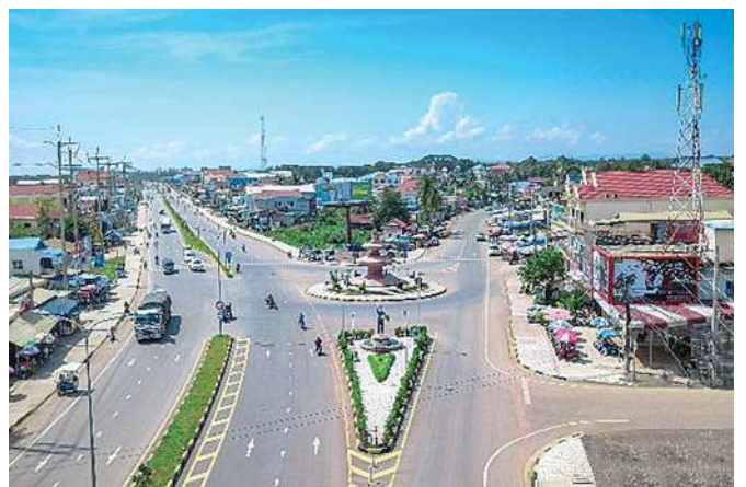
改修が完了した既存道路
