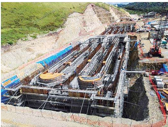
下水処理施設の施工状況
