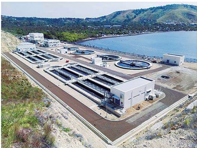
下水処理施設の完成後の施設全景
