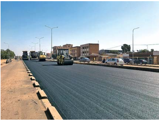
2班体制による舗装施工状況
