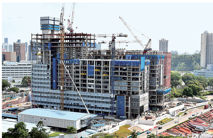
地上躯体でも生産性を向上
