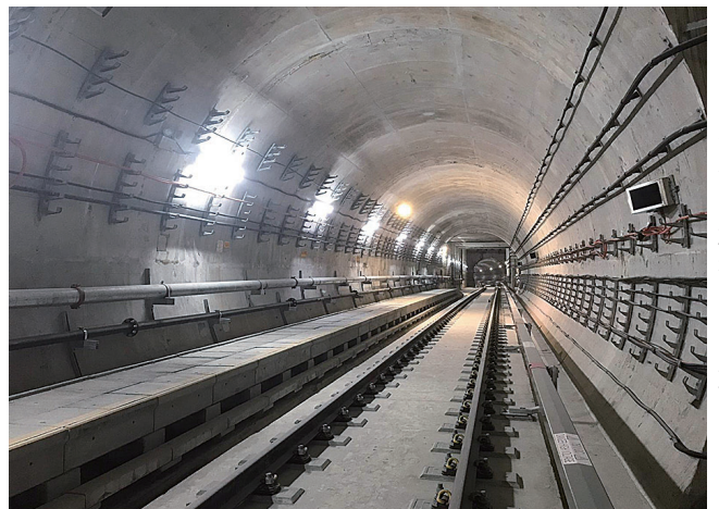
完成した軌道トンネル部
