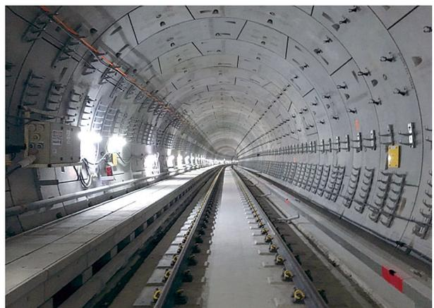
シールド機3台で4本のトンネルを構築
