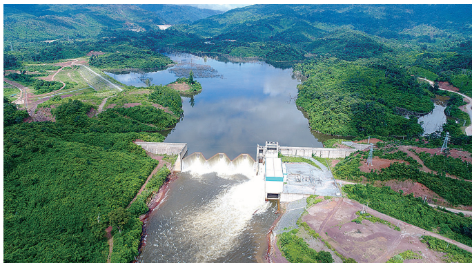
主ダムの放流水を一時貯留する逆調整ダム
