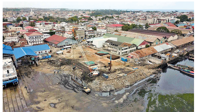
着工当初の改築現場の状況 (19年8月撮影)
