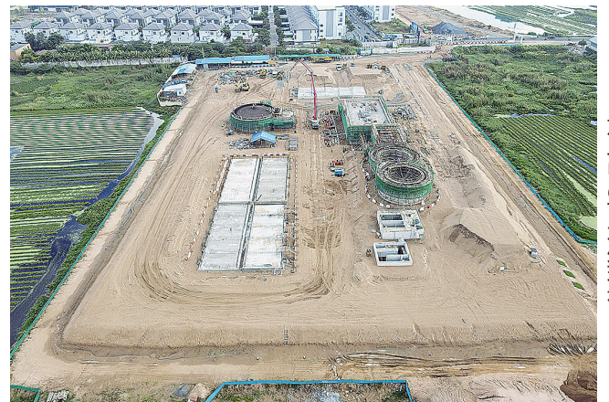
施工中の下水処理場
