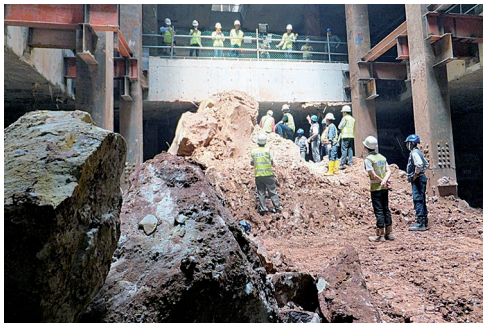
逆巻き工法で掘削中に出現した巨大転石
