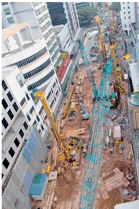
市街地の狭い空間での作業状況
