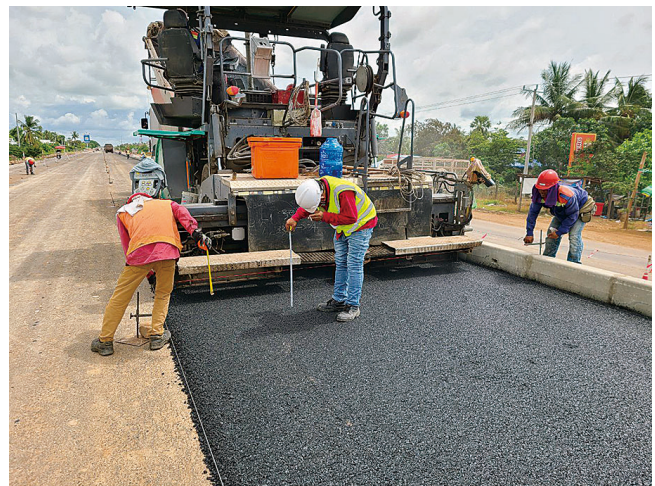
舗装工事での高さ管理状況
