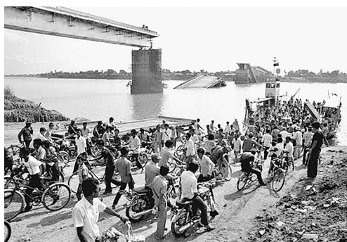
爆破で落橋した日本橋
