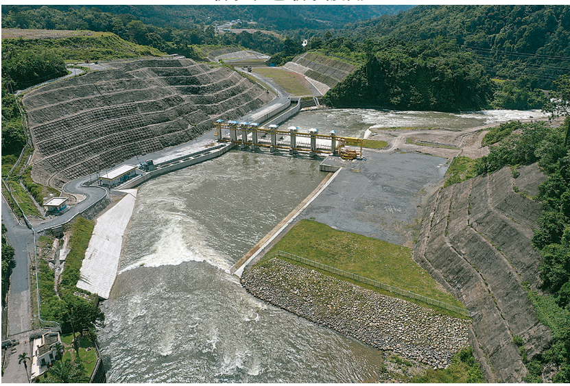
取水堰と取水設備
