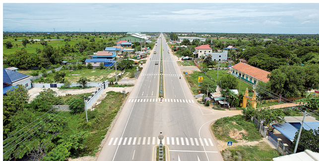
4車線化された一般道路部
