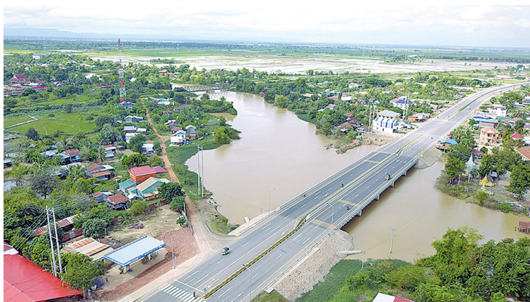
竣工後のNo.59橋梁
