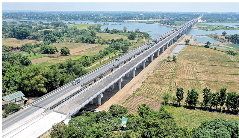
アンガット橋の全景
