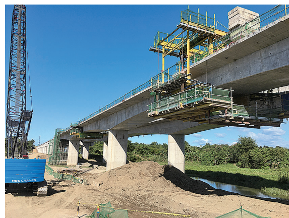
移動式作業車による主橋梁施工状況
