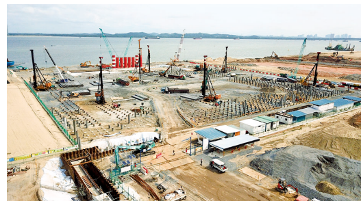
約6000本の杭を短期間で打設
