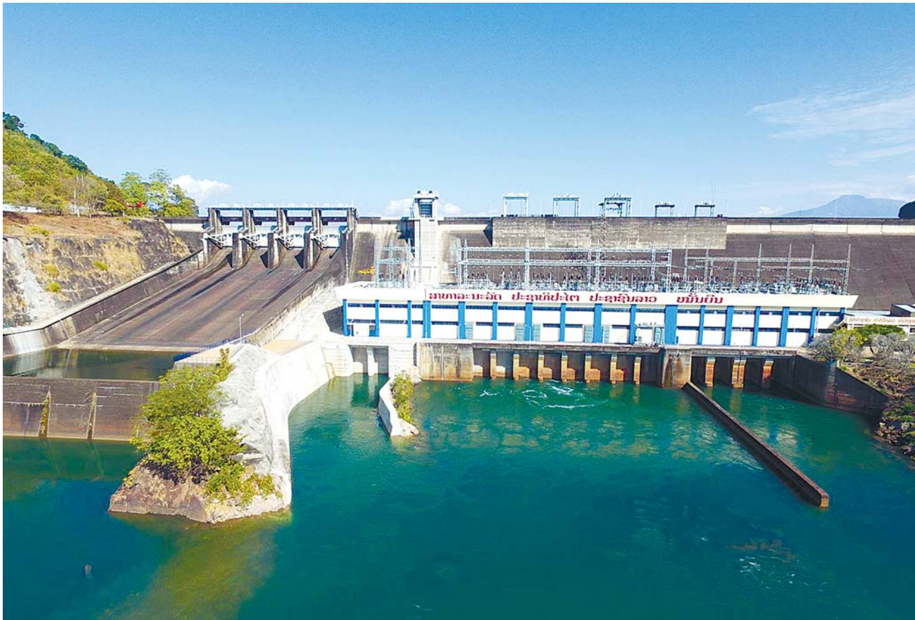
ナムグム第一水力発電所拡張工事 Lot. 1 (ラオス)
