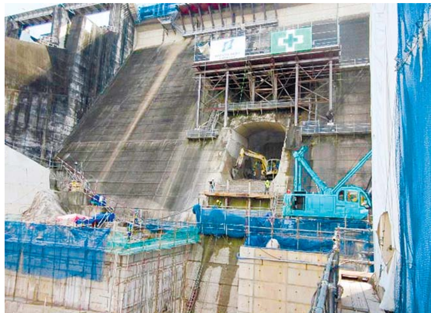
下流側貫通状況（19年9月）
