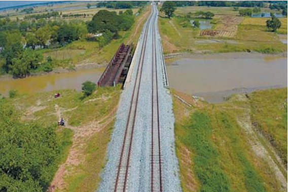
河川横断部の橋梁
