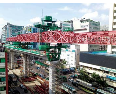
カルワンバザール駅渋滞区間でのLG架設とセグメント完成
