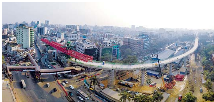
カルワンバザール駅方面への架設LG準備作業
