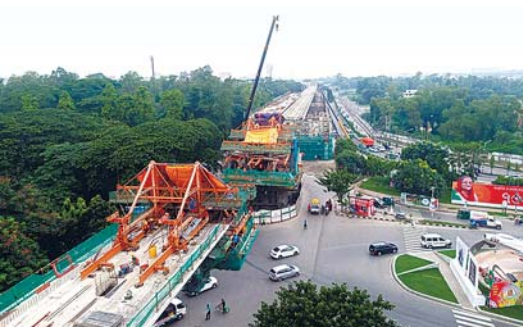
国会前区間の3径間PC箱桁橋施工中
