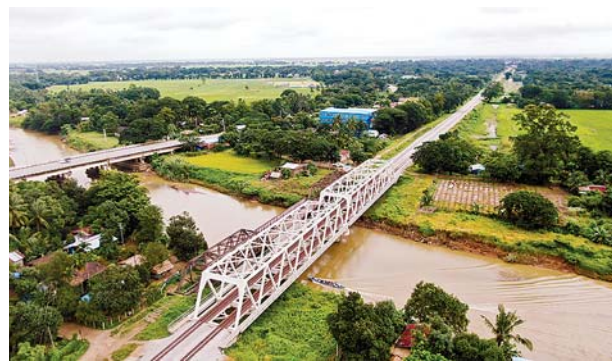
116B橋梁の全景
