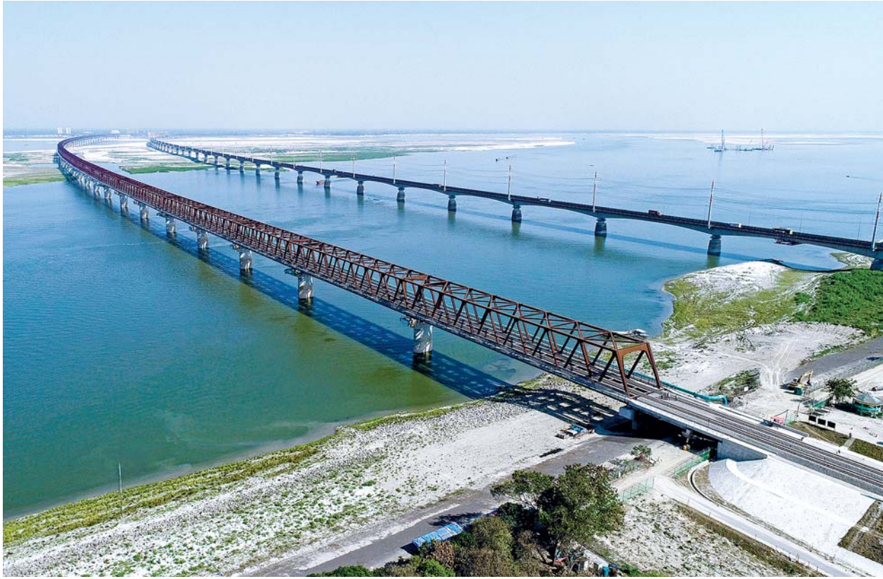
新設した橋梁。技術の力が東西をつないだ
