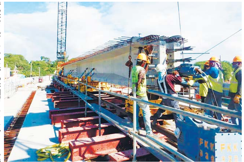
クロワ・デ・ミッション橋梁セグメント桁の緊張作業
