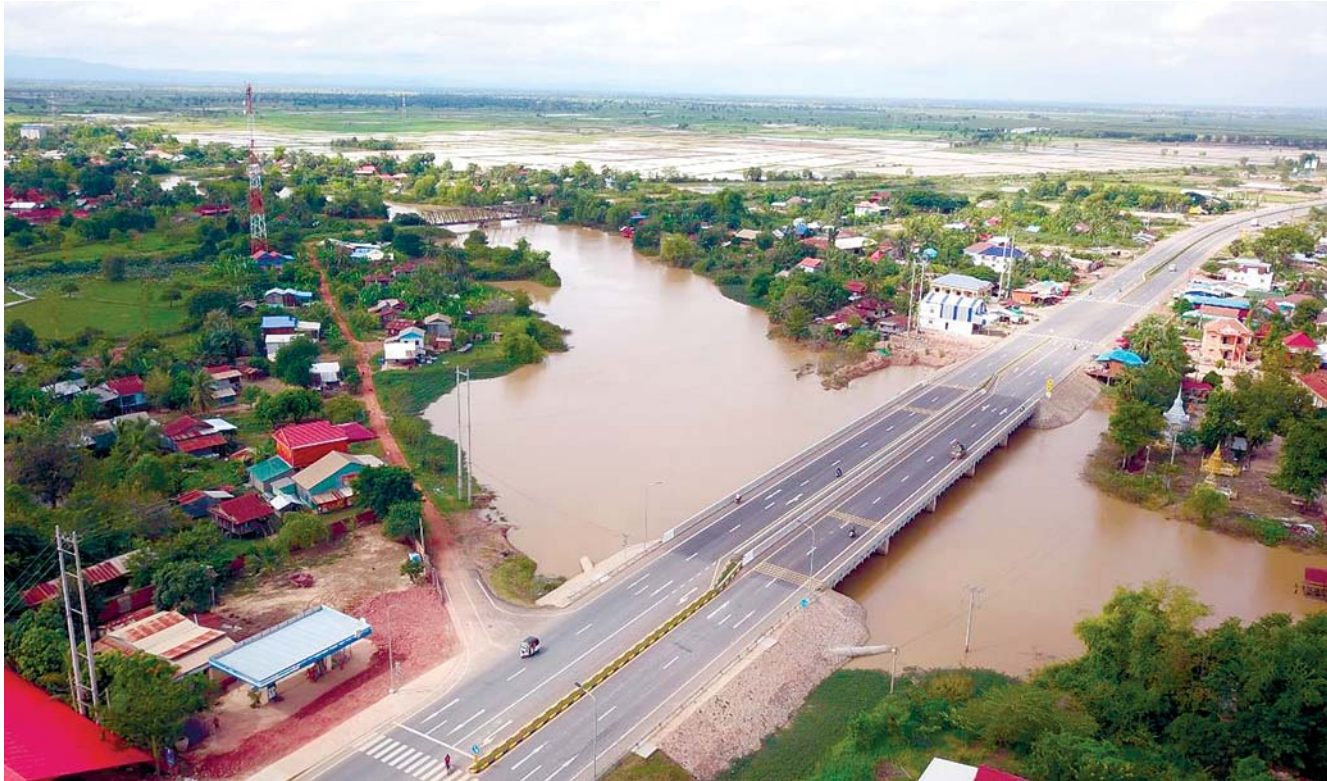
竣工後のNo.59橋梁
