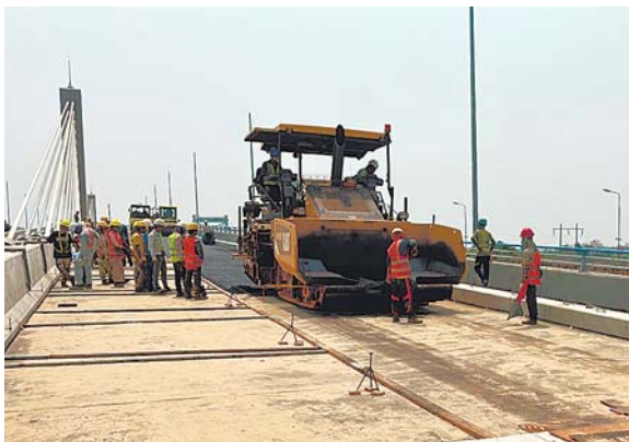
エクストラード橋の橋面舗装状況
