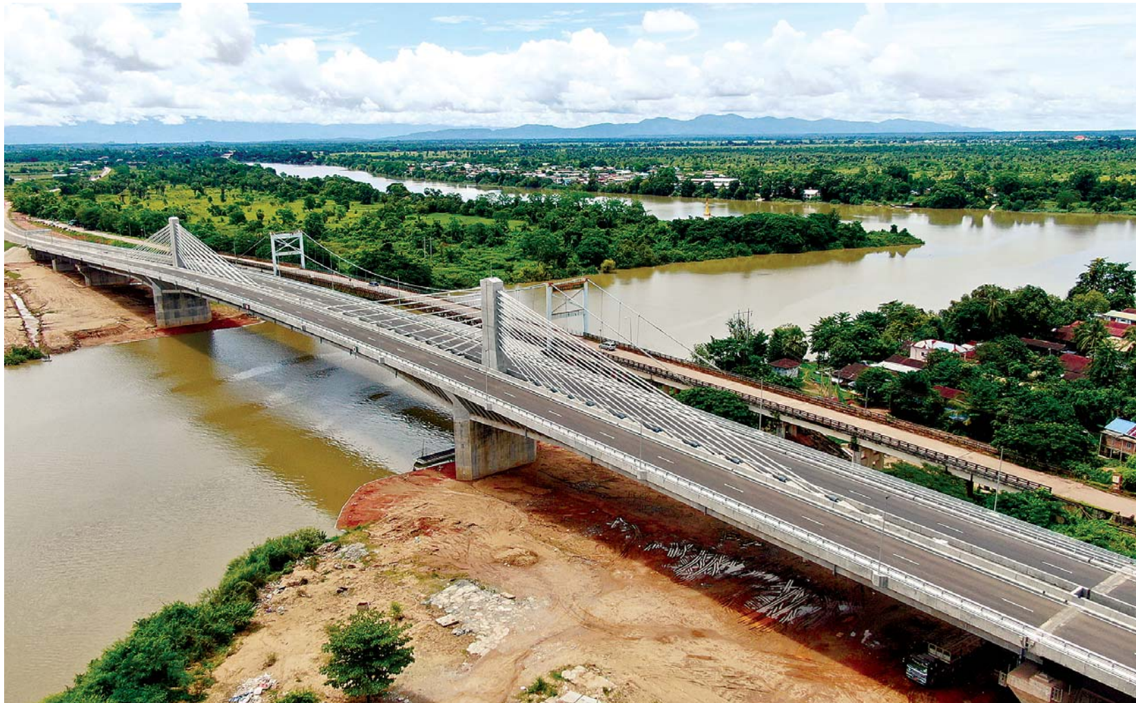
完成したジャイン・コーカレー橋
