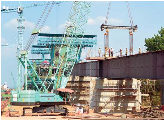
アプローチ橋の施工状況
