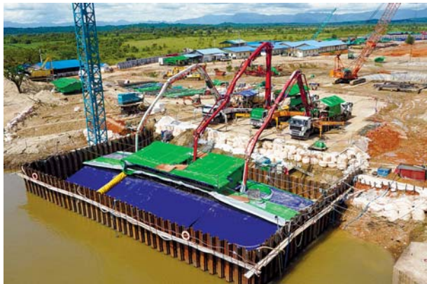
P 4フーチングの打設状況
