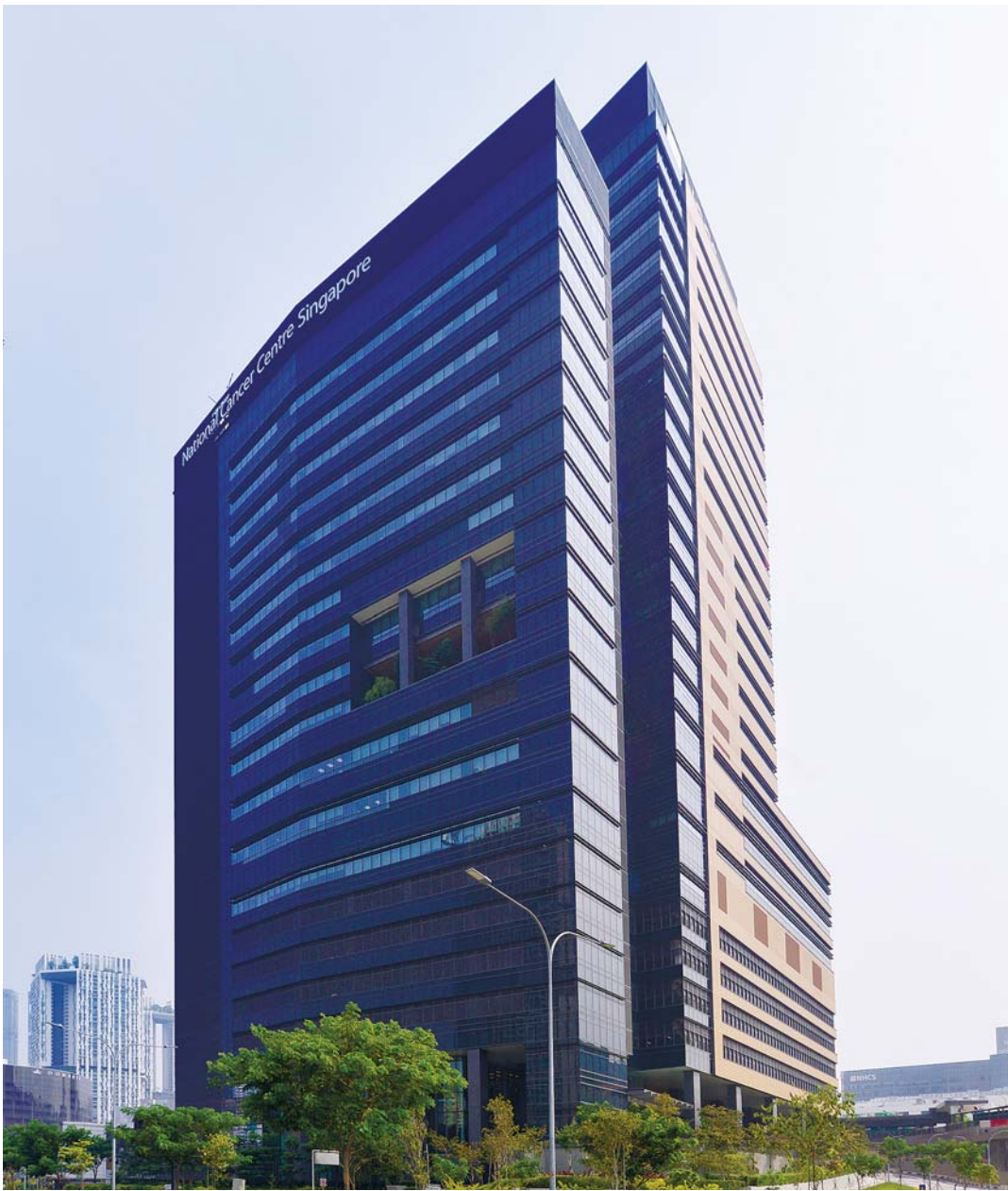
外装にはユニタイズ式カーテンウィールを採用し、高い意匠性を実現（一部テラコッタ仕上げ）
