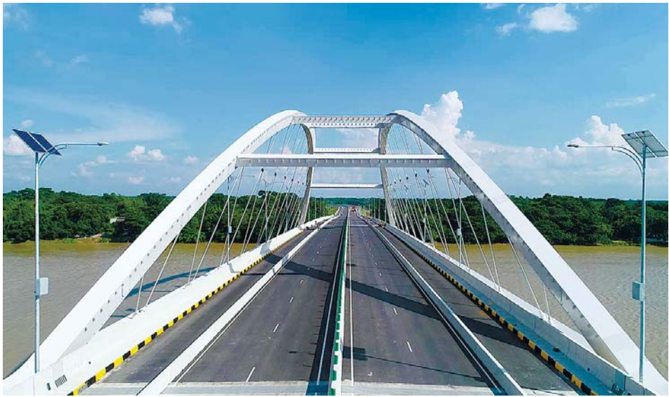
正面から見た主径間ニールセンローゼ橋
