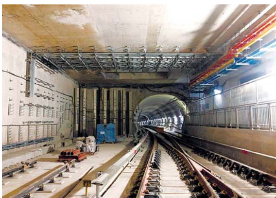
シールドトンネル全景
