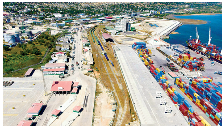
港湾エントランス道路と鉄道ターミナル
