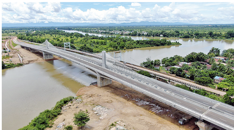
完成した橋梁（23年6月撮影）
