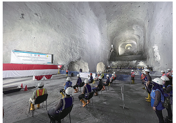
掘削が完了した地下発電所
