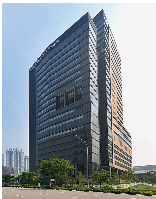
ユニタイズ式カーテンウォールを採用した外装
